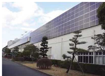
(キリン湘南工場、壁に太陽光パネル)
