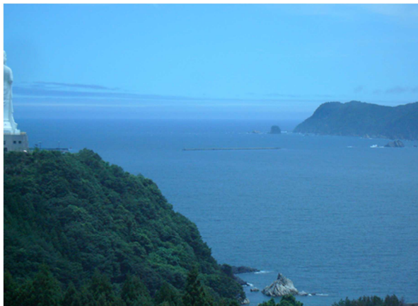
優美さを誇る釜石港湾の入口防波堤右側部分は破壊された。
