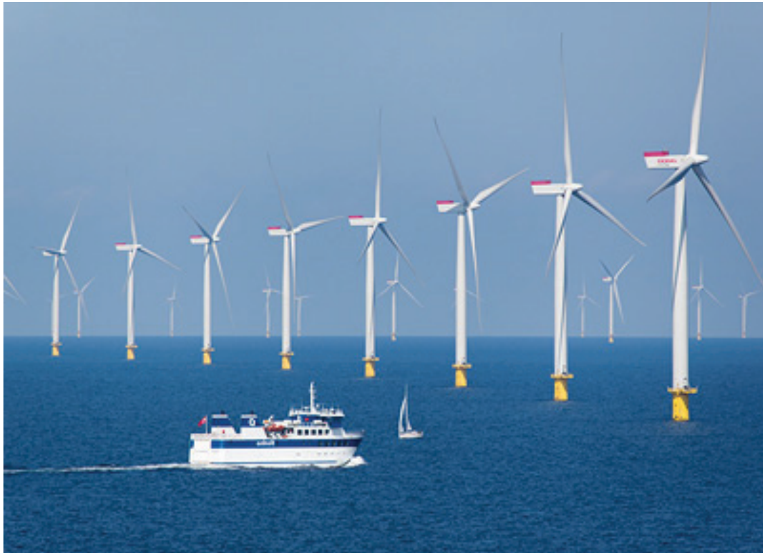
anholt 洋上風力発電所（デンマーク） （400MW, 111基）
