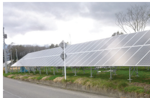
(柵塀未設置の事例)
